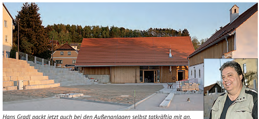
Hans Gradl packt jetzt auch bei den Außenanlagen selbst tatkräftig mit an.
