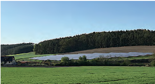
Die Anlage in Brendsdorf am Weg nach Stulln.
