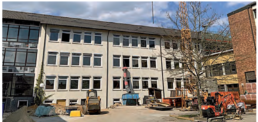
Während der Schulbetrieb ausgesetzt ist, sind die Bauarbeiten voll im Gang.
