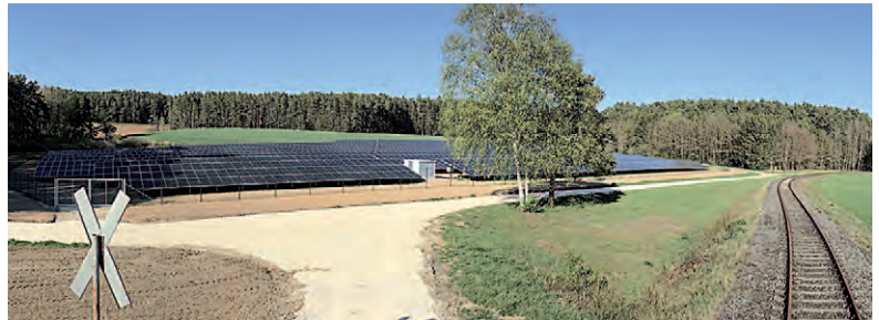
Die Solaranlage bei Frotzerricht liegt am Bahndamm nach Buchtal.
